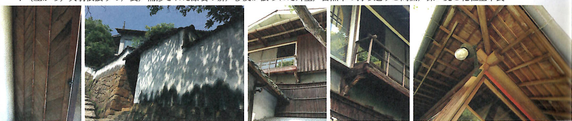
▼(左から) 矢羽根張りの戸袋/補修された漆喰の塀/杉皮が張られた外壁/自然木の持ち送りと高欄/深い庇と化粧垂木袋
